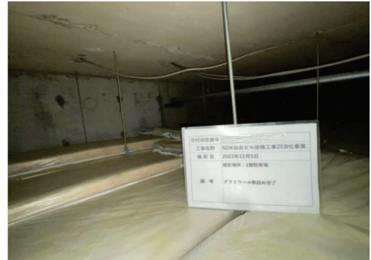
1階駐車場天井裏断熱材設置
