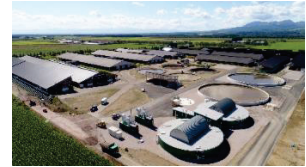
バイオガスプラント
