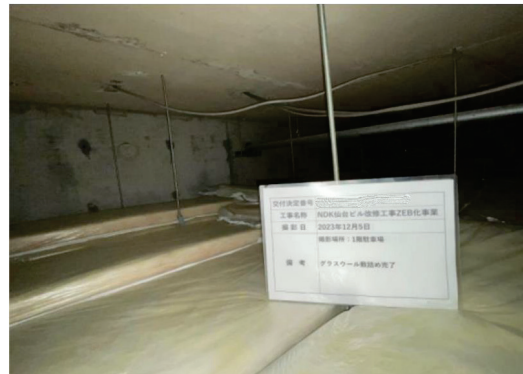
1階駐車場天井裏断熱材設置
