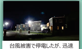
台風被害で停電したが、迅速に復旧した千葉県睦沢市
