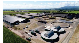
バイオガスプラント
