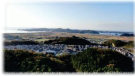
手前が高台移転した野蒜地区 奥が防災集団移転元地
