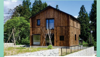
山形県の高断熱省エネ住宅
