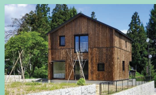
山形県の高断熱省エネ住宅
