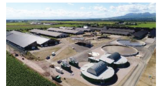
バイオガスプラント
