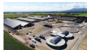
バイオガスプラント
