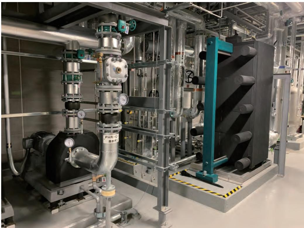
DHC機械室 / 冷温水ポンプ・プレート式熱交換機
