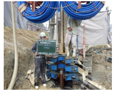
地中熱交換器挿入工事
