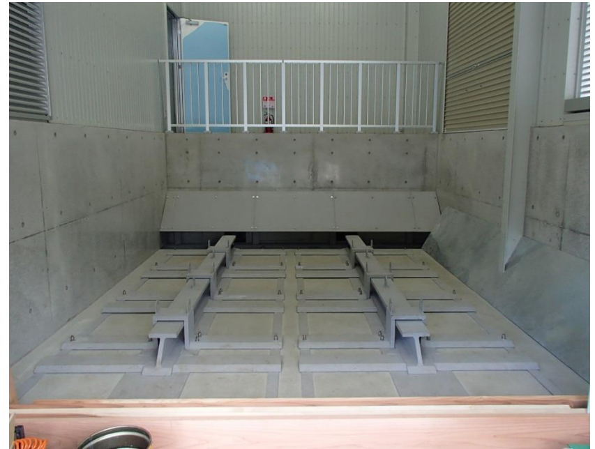
チップサイロ工事の様子
