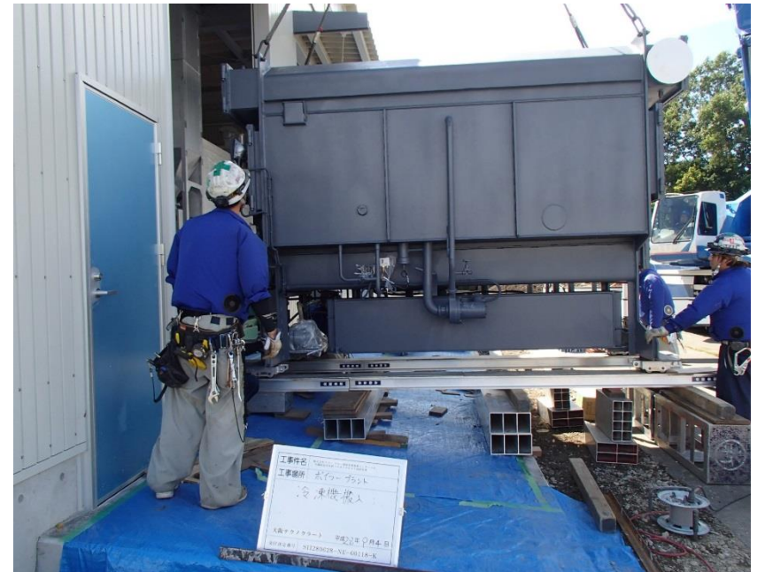
吸収式冷凍機搬入の様子
