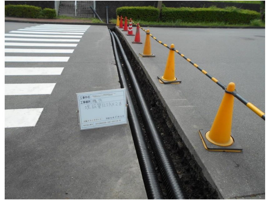
熱導管の埋設の様子
