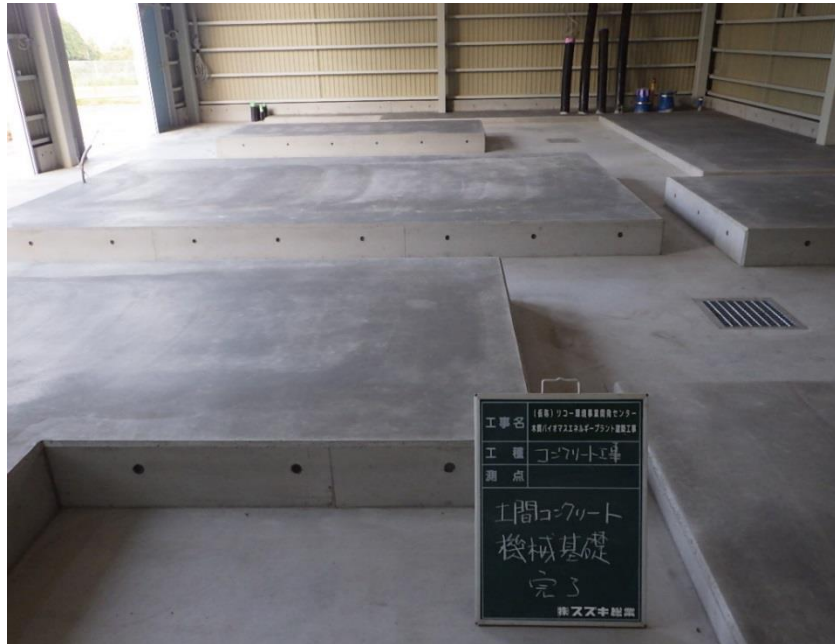
基礎工事の様子
