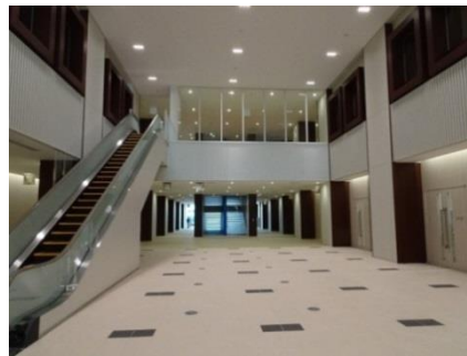
熱利用場所 （エントランスホール）
