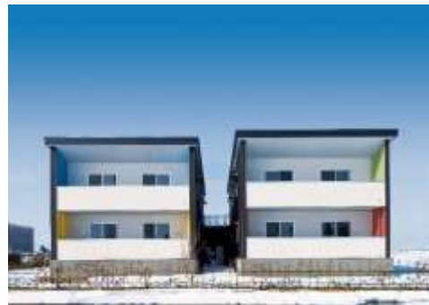
「CLT集合住宅」 湯川村にて建設
