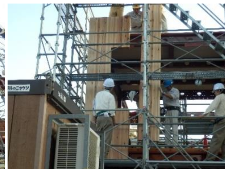
壁パネル取り付け (2日間)
