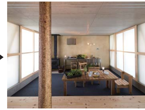
完成した土塗り壁。伝統的な材料を、パッシブな環境装置（蓄熱間仕切り壁）として用いる。
