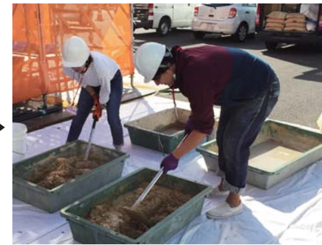
現場で、土・水・藁を配合し、翌日の施工に備える。
