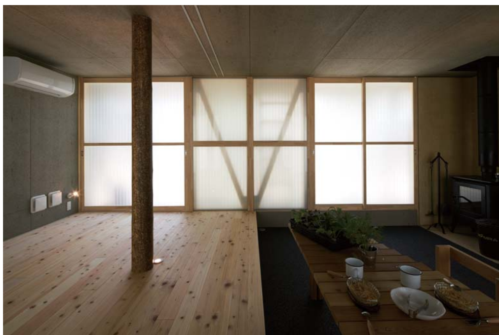
南北面に設置した、透明断熱材による「光を通す構造壁」(U=0.27)
