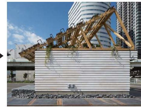
完成した外壁。外壁を白く塗ることで、屋上の「グリーンハット」が引き立っている。
