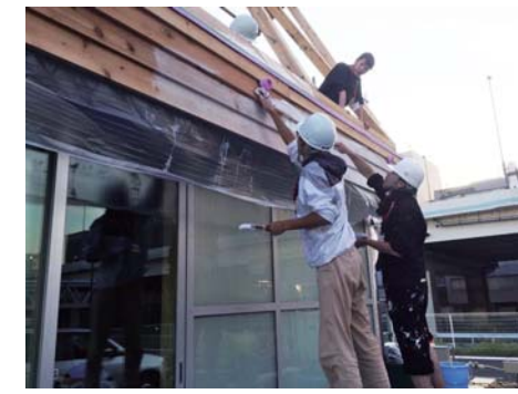
学生による外壁塗装の様子。可能なことはDIYで行うコンセプトの実施。塗料は水性塗料。
