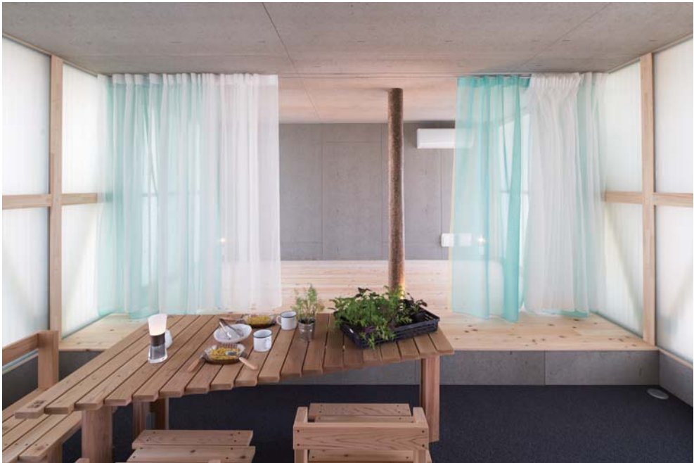
光を通す構造壁による明るい室内。木琴テーブル・チェアは学生によるデザイン。
