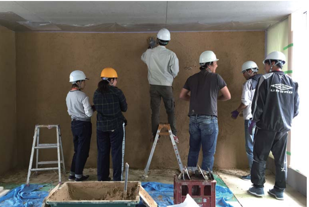
蓄熱間仕切り壁となる土塗り壁は、DIYで施工可能。(学生による施工の様子)
