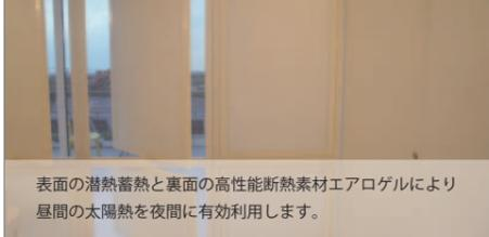
表面の潜熱蓄熱と裏面の高性能断熱素材エアロゲルにより昼間の太陽熱を夜間に有効利用します。
