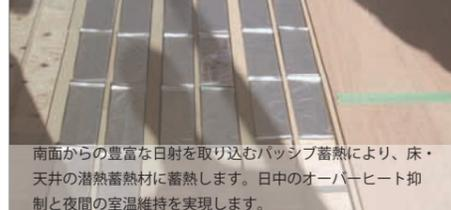
南面からの豊富な日射を取り込むパッシブ蓄熱により、床・天井の潜熱蓄熱材に蓄熱します。日中のオーバーヒート抑制と夜間の室温維持を実現します。
