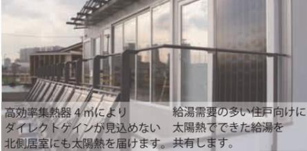
高効率集熱器 4m によりダイレクトゲインが見込めない北側居室にも太陽熱を届けます。共有します。
