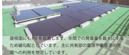
屋根にも PV を設置します。年間での発電量を最大にするため緩勾配としています。主に共有部の電源や蓄電池の充電への利用を想定しています。
