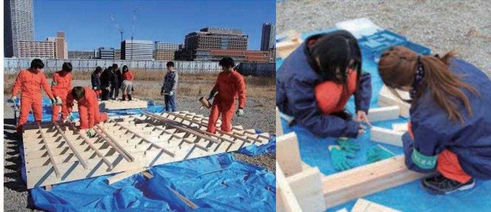
“誰でも出来る施工”の実証実験を目指して、学生が主体となって参加する工事を設計段階から計画してきたため、内装工事にとどまらず、あらゆる所に学生による成果が現れています。今回の家を大きく包む格子状の“呼吸する屋根”は、設計段階から意匠・構造・設備の先生方と多くの議論を重ねながら作り上げた屋根です。総勢70名程度の学生が大学周辺の仮工事場で施工した屋根は、CLTの環境シェルターとともに東雲駐車場へと運ばれました。
