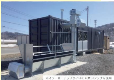
ボイラー室、チップサイロに40tコンテナを使用
