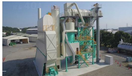
アスファルトプラント後景
