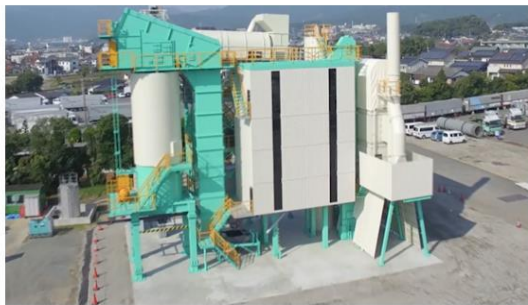
アスファルトプラント前景
