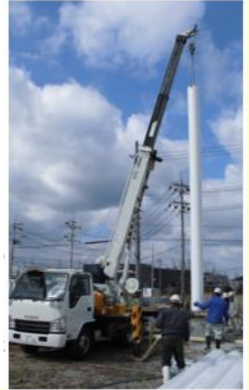
建駐車による地中熱交換パイプ施工
