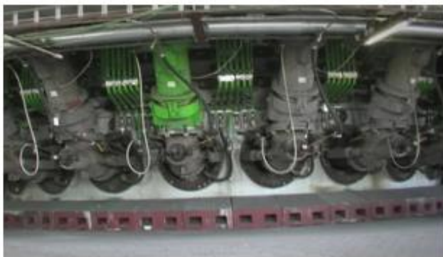
導入事例 外観
