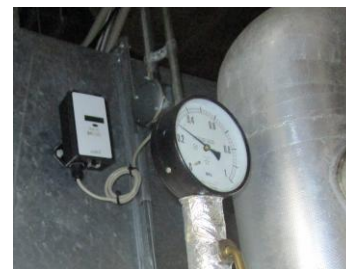
ダクト挿入型CO 2 センサ
