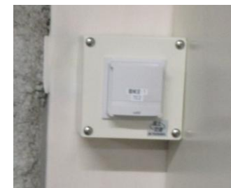
機械室 室内用温度センサ
