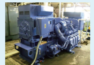
3. ターボコンプレッサ 吐出容量 6,000m³/h (※)
