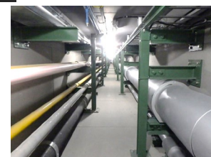
自社専用共同溝での蒸気融通
