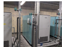
コンプレッサー× 1台 吐出空気量：12.7m 3 /min (※)
