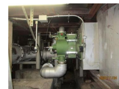
マグネシウム溶解炉 リジエバーナー
