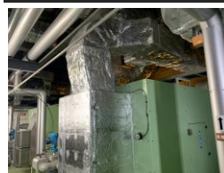
ヒートパイプ熱交換機
