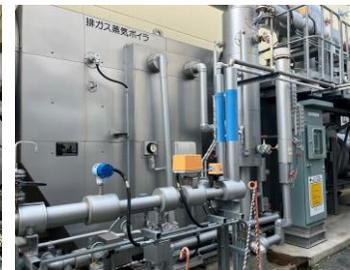
排ガス蒸気ボイラ蒸発量：
