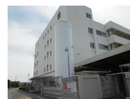
LNGタンク×1台 容量:60kl
