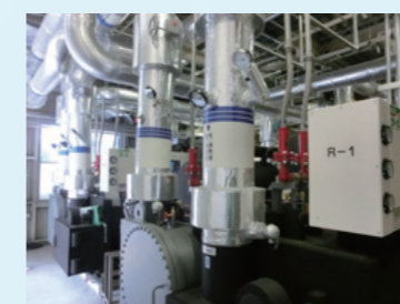
4. ヒートポンプ型ターボ冷凍機 197kW (冷房) (※)
