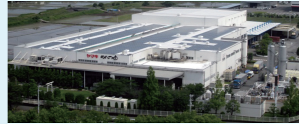
第二工場外観
