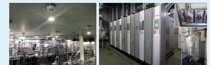
2. LED照明 200W型 消費電力 71W 3. ボイラ・保温設備 能力 2.0t/h
