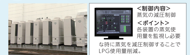
4. 空冷式チリングユニット 冷却能力 150kW 5. エネルギーマネジメントシステム
