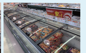
ショーケース 消費電力 4.09kW (※)
