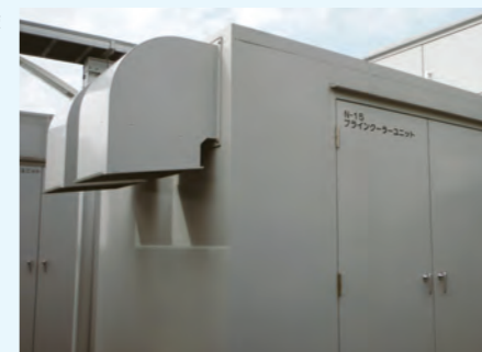
1. 高効率型アンモニア冷凍機 冷却能力 1,941kW (500JRT)
