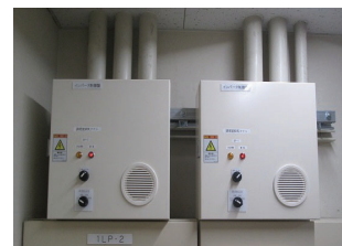
インバータ盤設置後 (After inverter panel installation)
