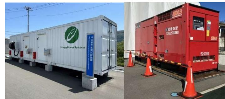
エクセルギー電池システム+ディーゼル発電機
