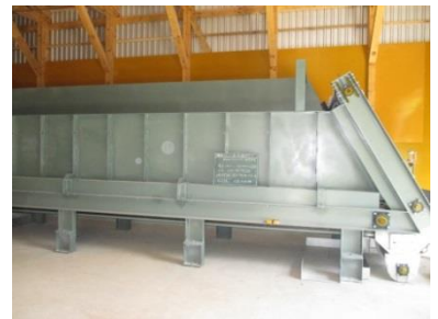
定量供給器排出コンベア
