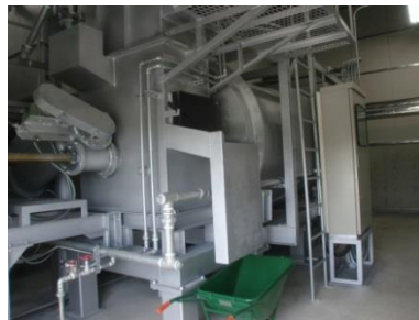
バイオマスボイラー
