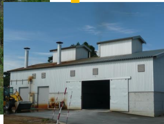
バイオマスボイラー棟
