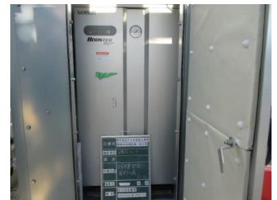
バイオマスボイラー
