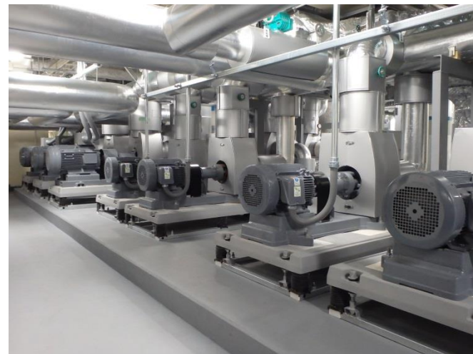
放熱ポンプ（計7台）
