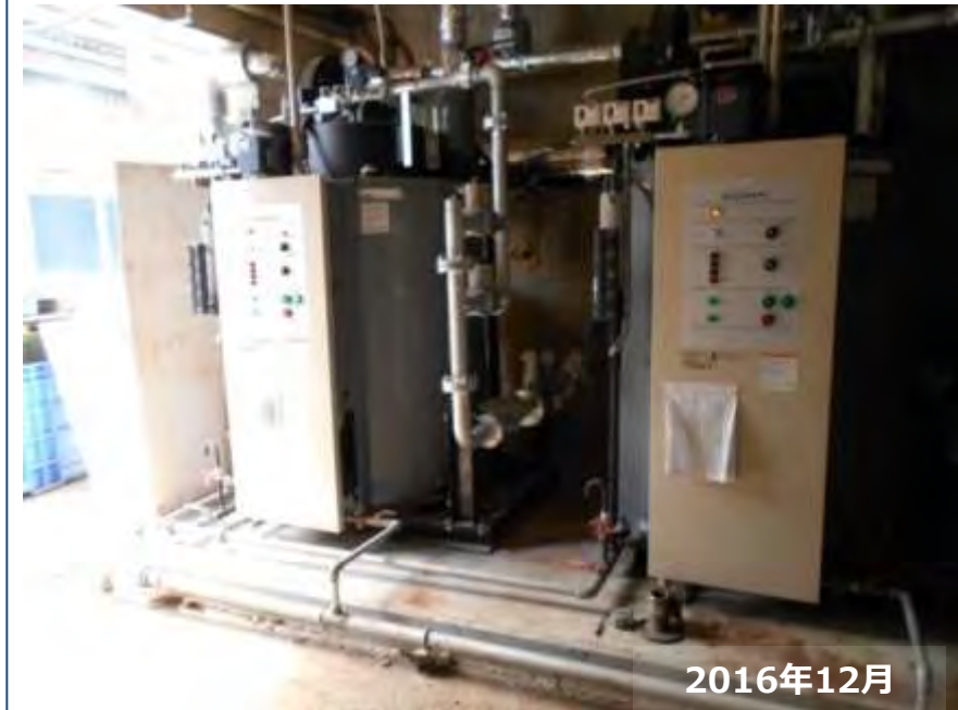
バイオマス熱利用設備
