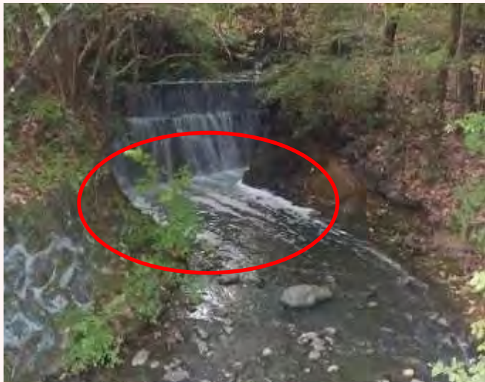
EGSB設置前の排水路 (落差のある場所で泡立つ事があった)
