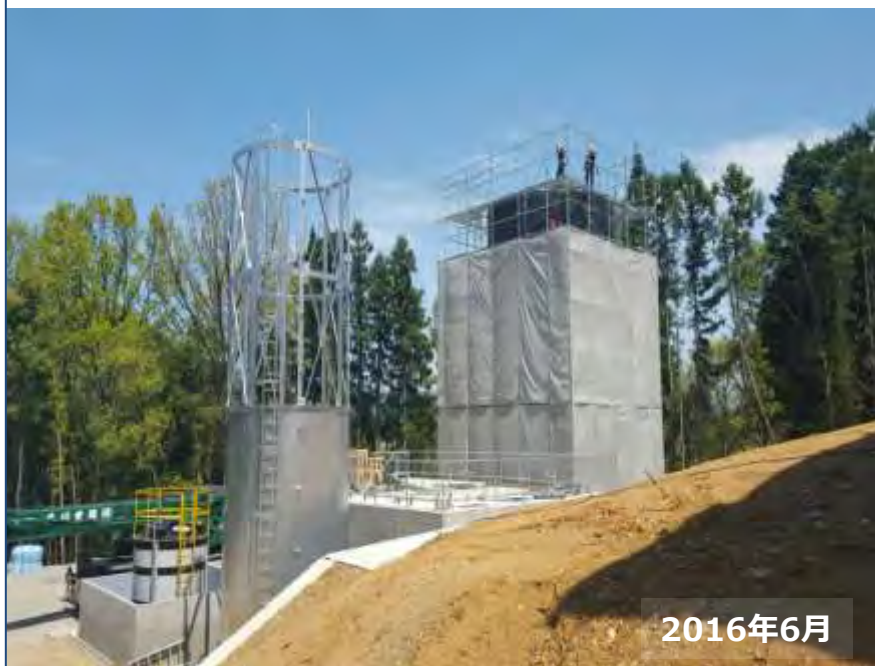
反応槽組立中
