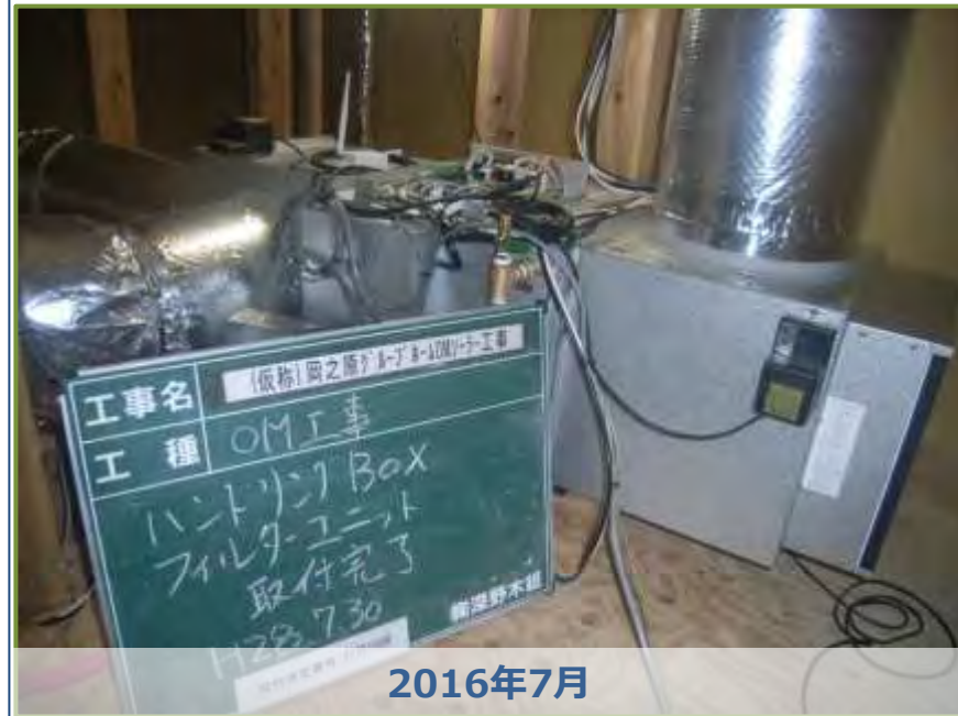
ハンドリングBOX・フィルターユニット取付完了 OMソーラー株式会社製 ハンドリングボックスOMD-12FB2
