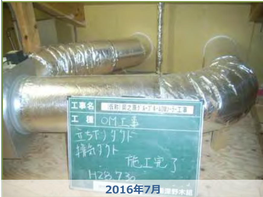
立下り・排気ダクト施工完了
