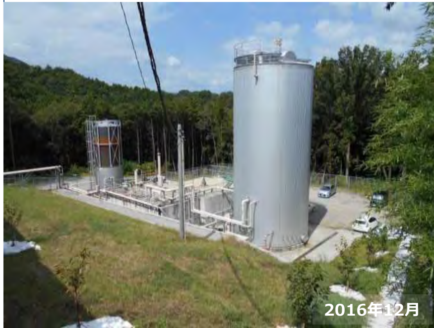
バイオマス燃料製造設備
