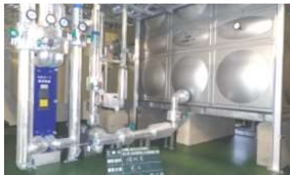
熱源槽と熱交換器
