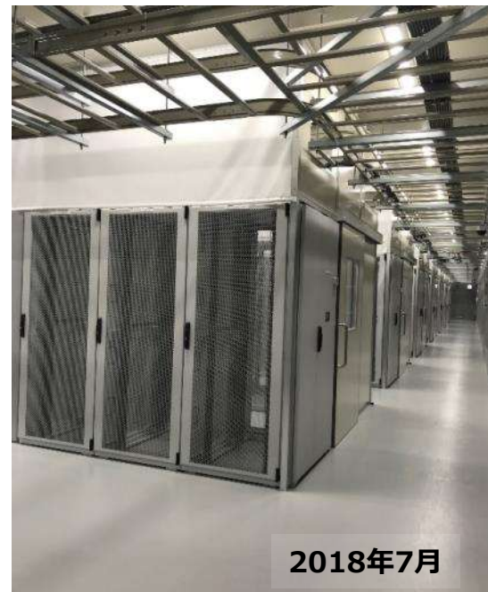
サーバラック
