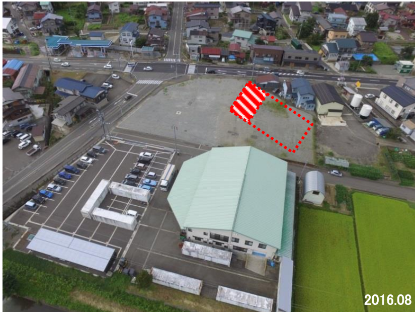
施工前整地した予定地
