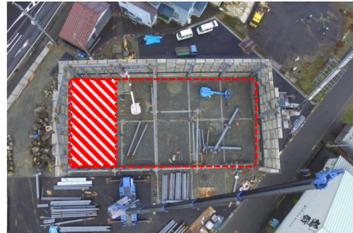
生コン基礎、鉄骨建て
