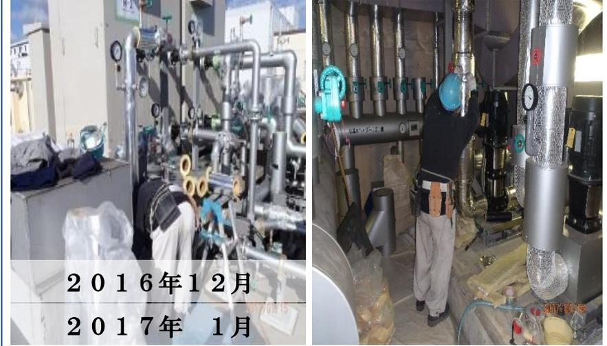
空調が止められなかった為、故障中の1号機を先に撤去・更新。残った既存機で冷房・暖房を継続。
