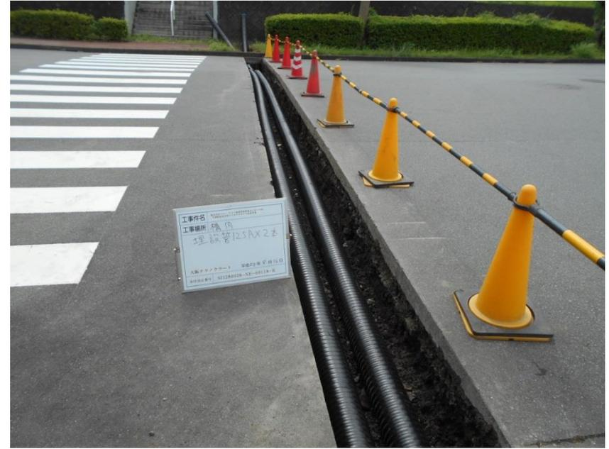
大型トラックの通行エリアへ熱導管を埋設する必要があったため、弊センターの夏季休業中に埋設工事を実施。
