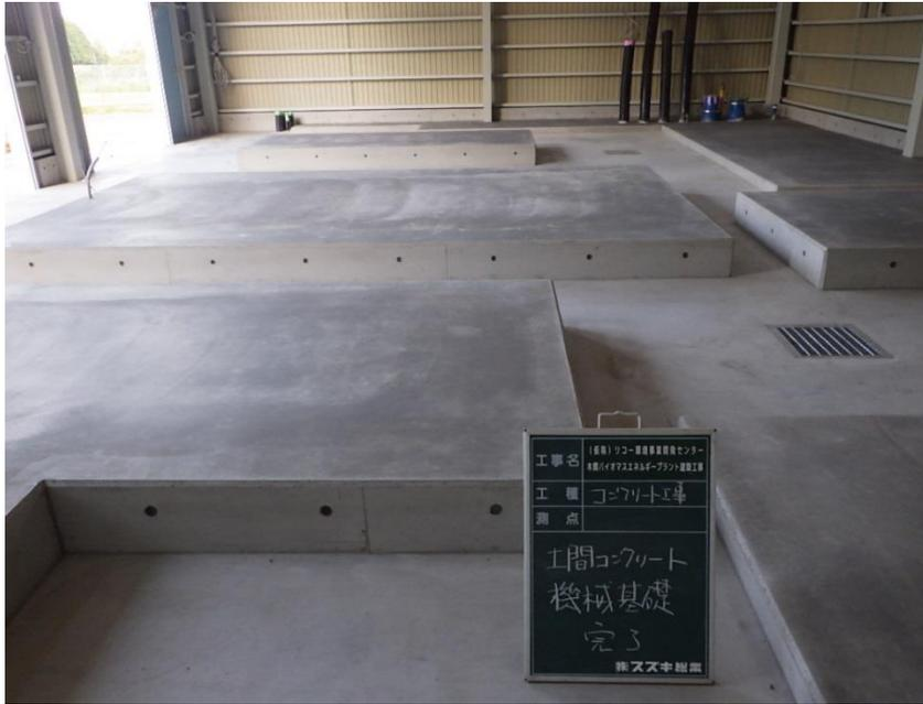
建屋内の基礎工事が完了し、木質バイオマスボイラーの設置準備が整った。
