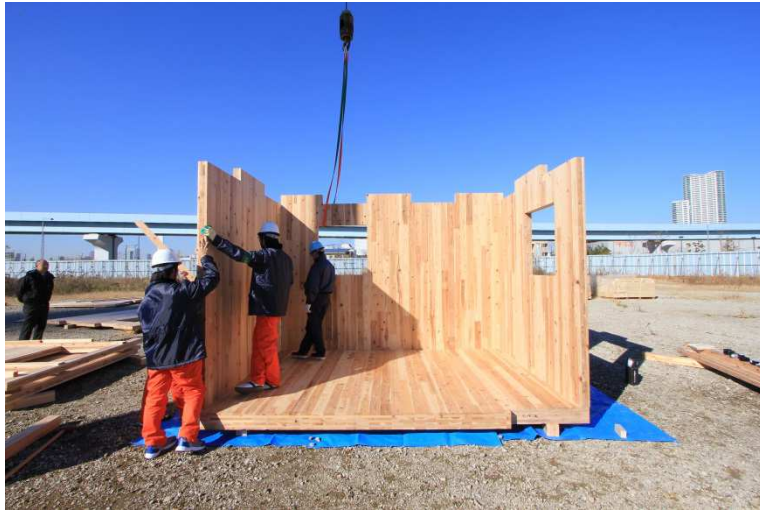
シェルターの組み立て
