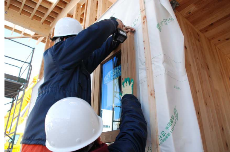
窓の取り付け
