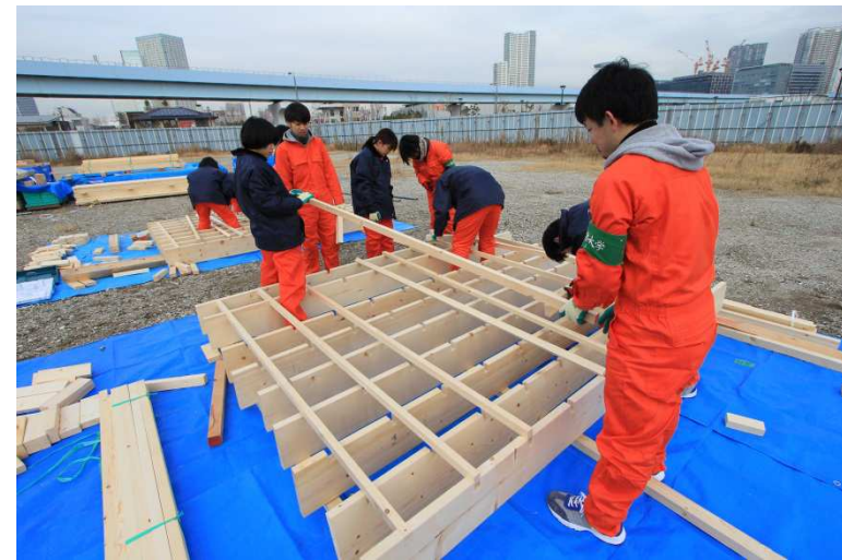
屋根架構の組み立て
