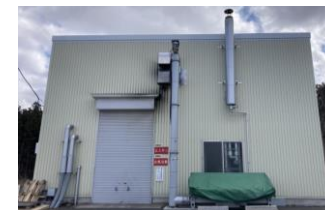
木質チップボイラ 建屋外観
