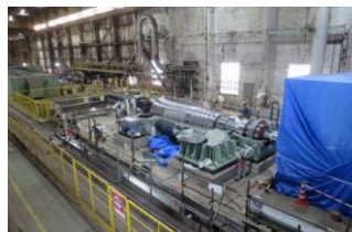
屋内設備（建設中）
