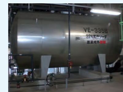
3. 陰極液受槽 圧力30～40KPaG (3,000～4,000mm水柱)
