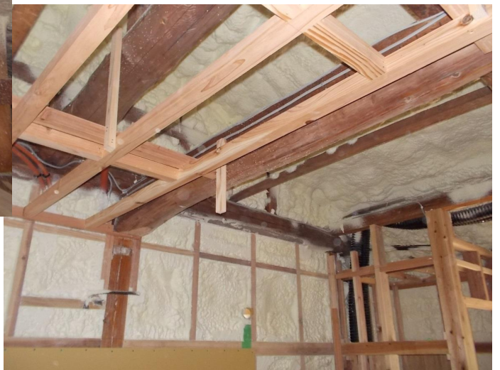
天井及び壁断熱材 吹付け状況
