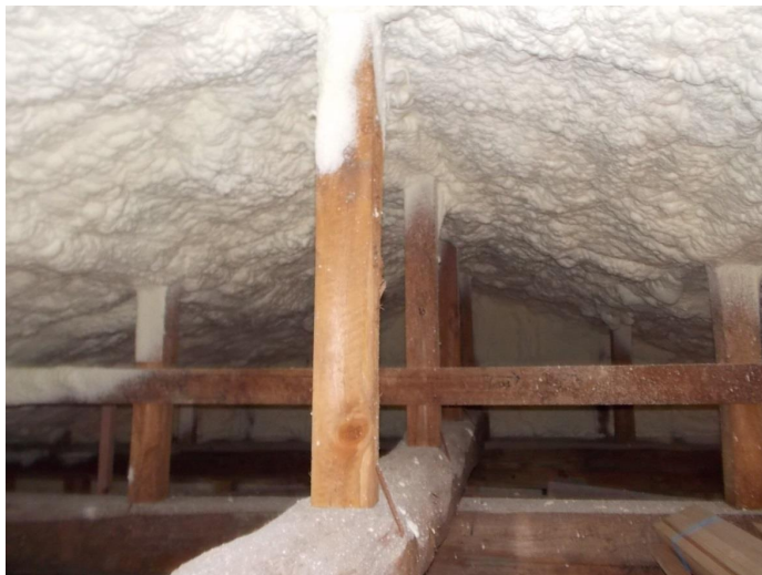
天井断熱材 吹付け状況
