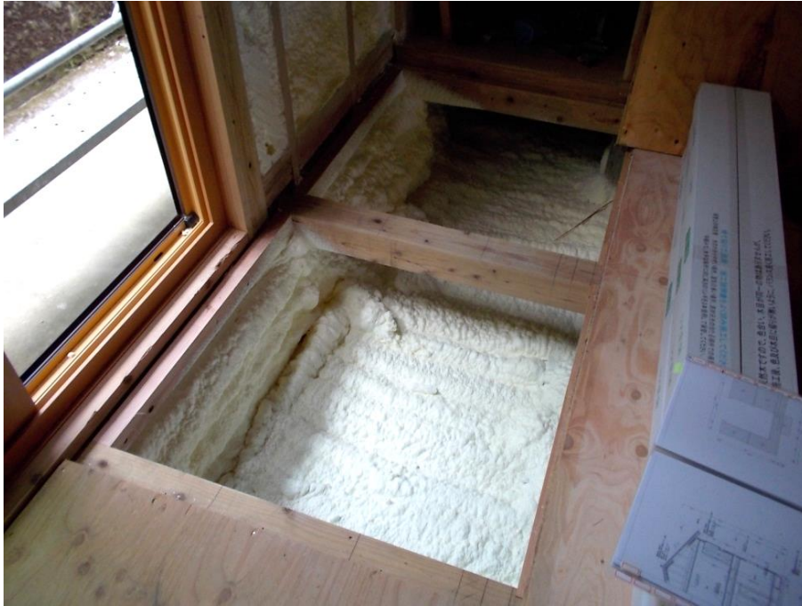
基礎断熱材 吹付け状況
