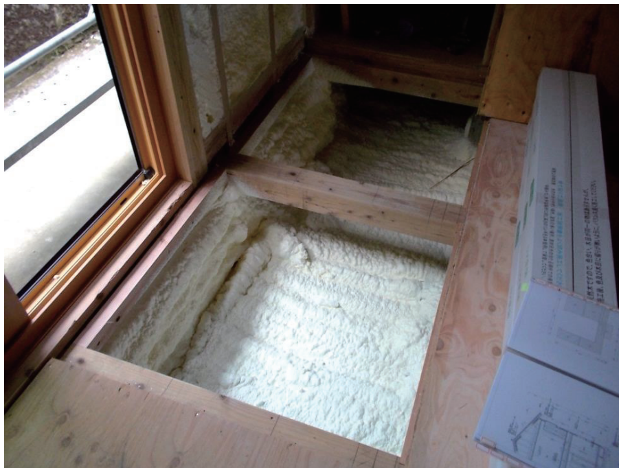
基礎断熱材 吹付け状況
