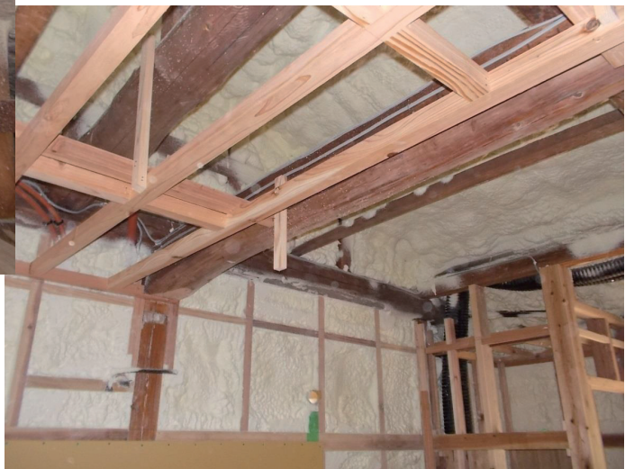
天井及び壁断熱材 吹付け状況
