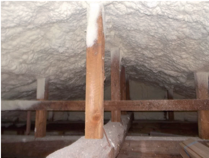
天井断熱材 吹付け状況
