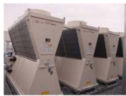
●空冷ヒートポンプモジュールチラー
