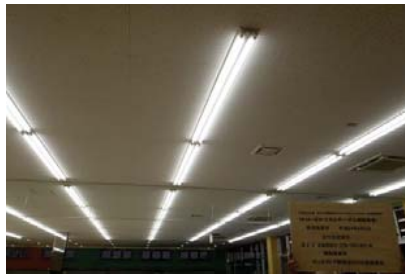
インバータ式高効率照明器具及びLED照明器具、(照度補正)
