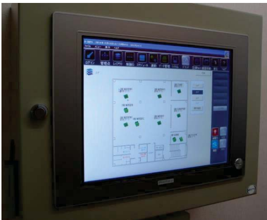
ビル総合監視盤 空調を一括監視制御により、 省エネ管理が出来ます
