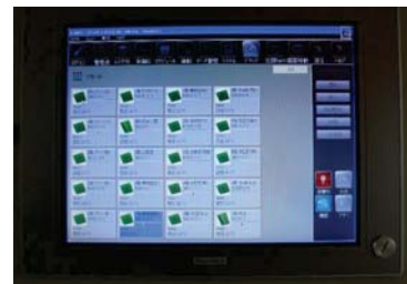
ビル総合監視盤 空調を一括監視制御により、 省エネ管理が出来ます
