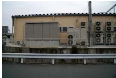
高効率インバータ式ヒートポンプエアコン及び、水蓄熱エアコン 空冷ヒートポンプ給湯器
