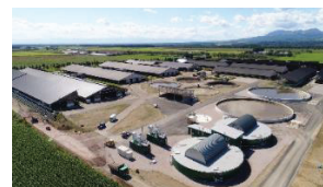
バイオガスプラント
