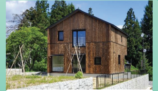
山形県の高断熱省エネ住宅
