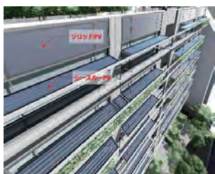
多機能庇 (日射抑制+採光+発電+緑化)
