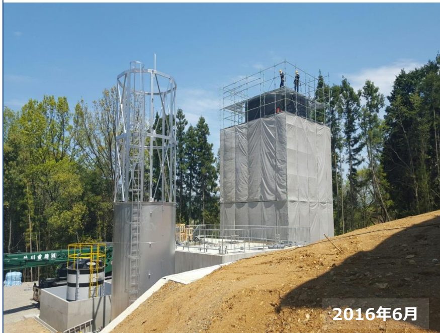
反応槽組立中
